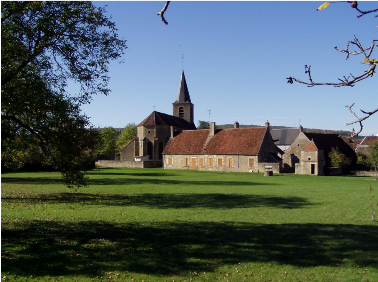
Église, presbytère, puits et pigeonnier de Châteauneuf
